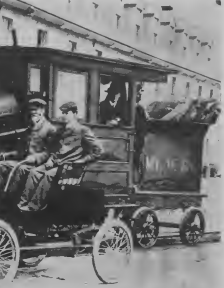
NA 1904, F. E. Stanley a corré subí Mount Washington di 6000 pi na New Hampshire den 27 minutos. E auto ta muestrá aki banda di un locomotiv di ferrocarril di e ceru. E ketel a wordé poní arba un canto pa subí ceru aña cu e ta keda horizontal na e subida.
